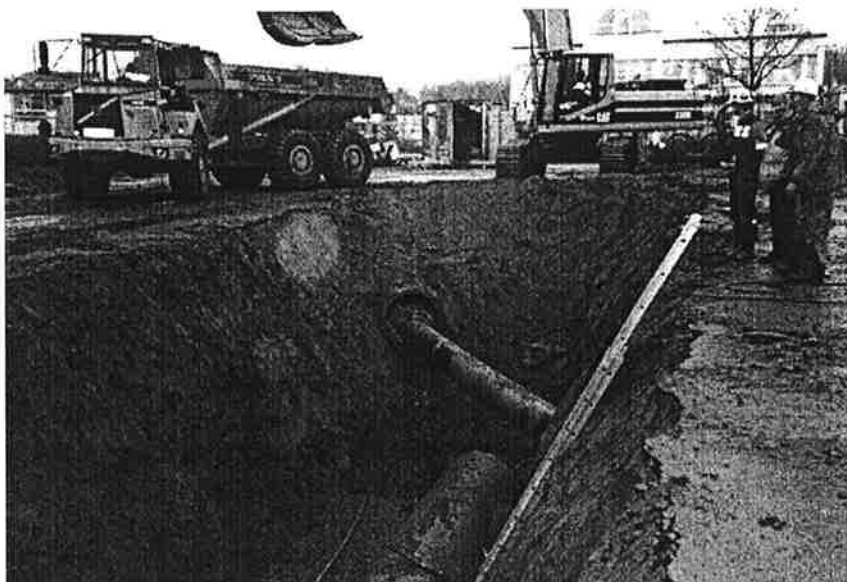
Kryssing av eksisterende avløp, Torget, Kleppekrossen.
