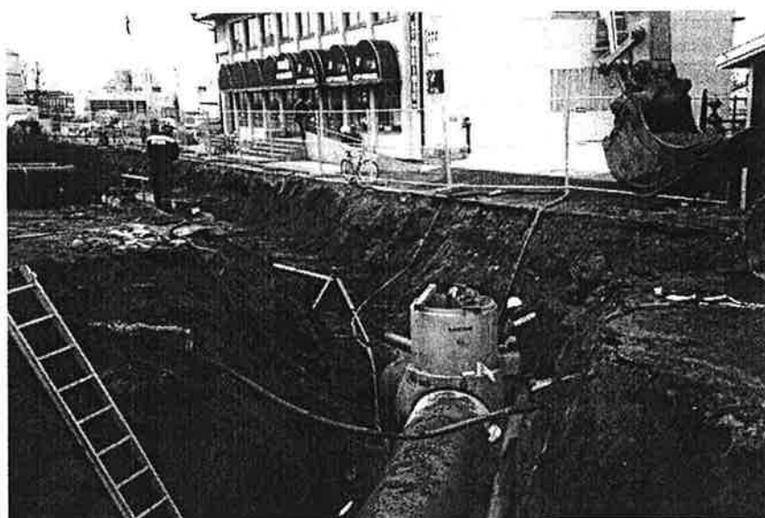
Grøftetrasé i Torgveien, Kleppekrossen.
