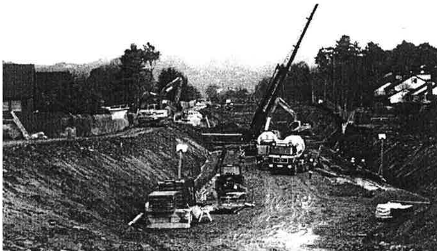
Betongarbeidene er startet på miljøtunnelen.
